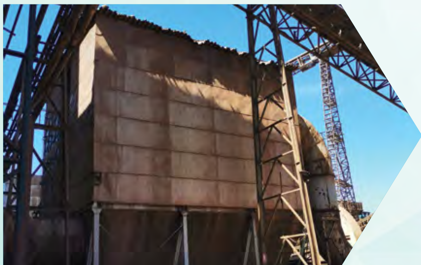
Врекест филтер во Подготовка на руда – Дробење
