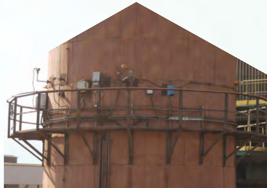
Дел од инсталираната опрема за континуиран мониторинг на емисии
